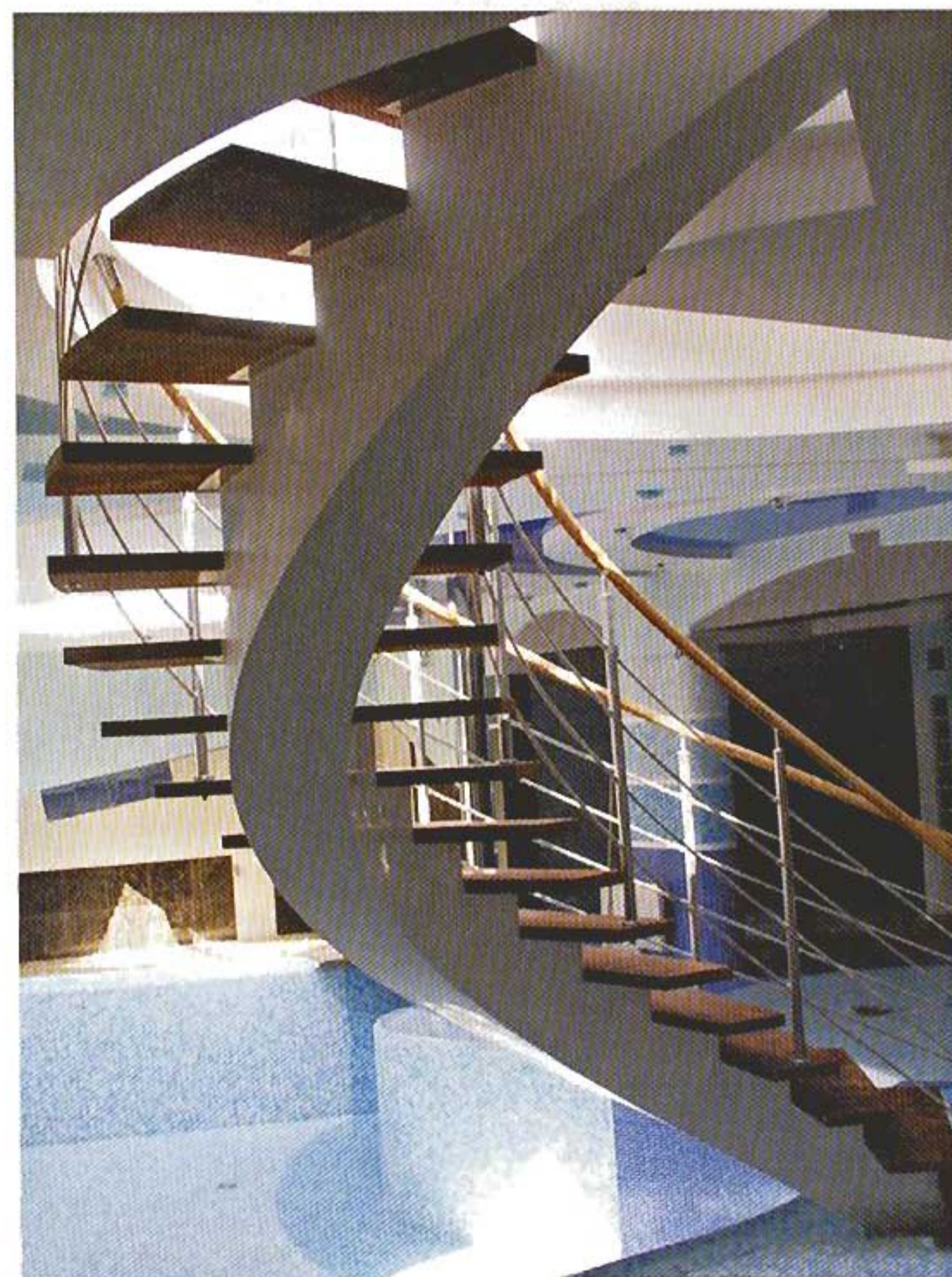
Nosná část z monolitického betonu, zábradlí je vedeno nášlapky
