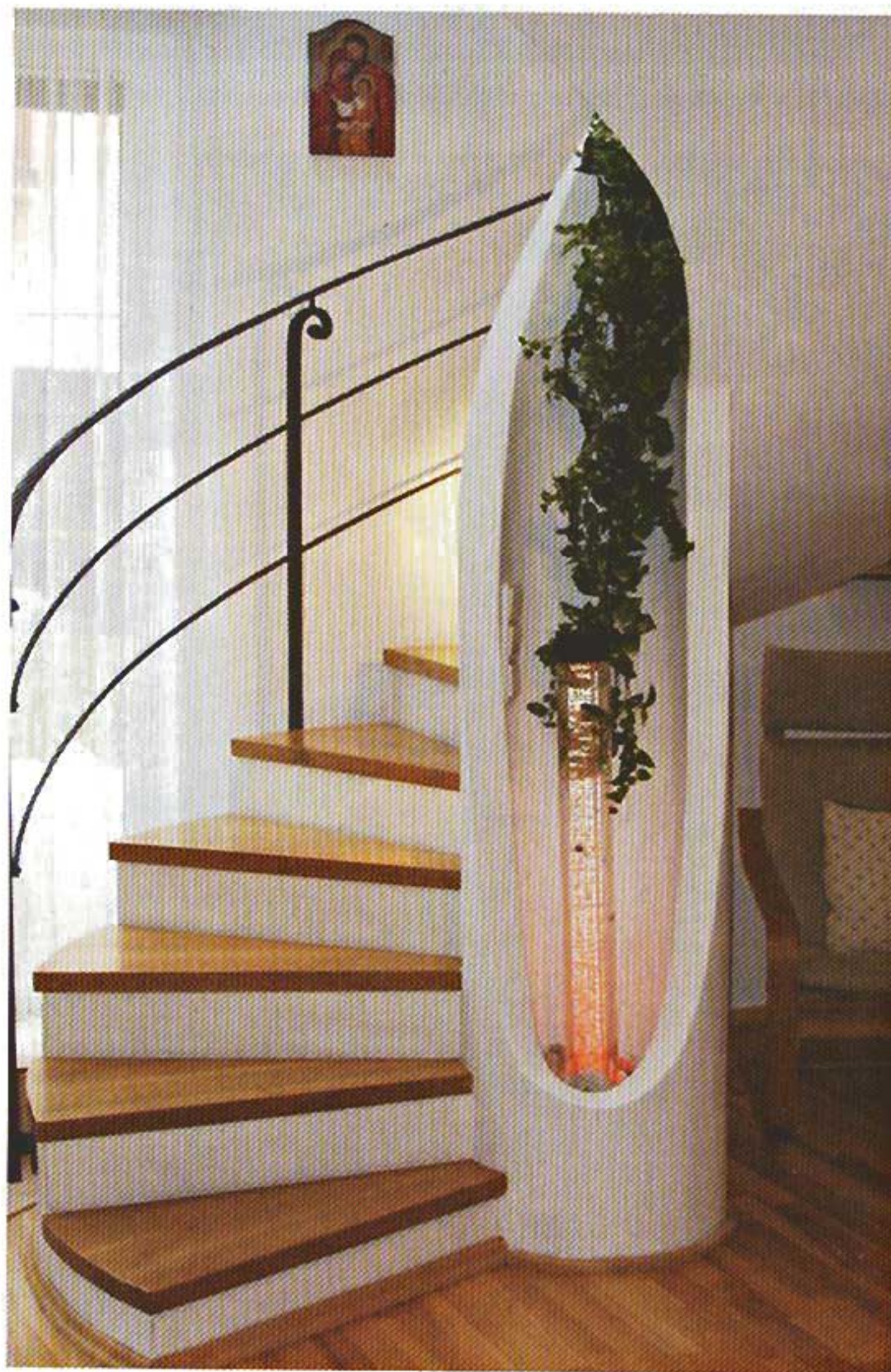
Vřetenové schodiště z betonu, odlehčené dřevěnými nášlapy
