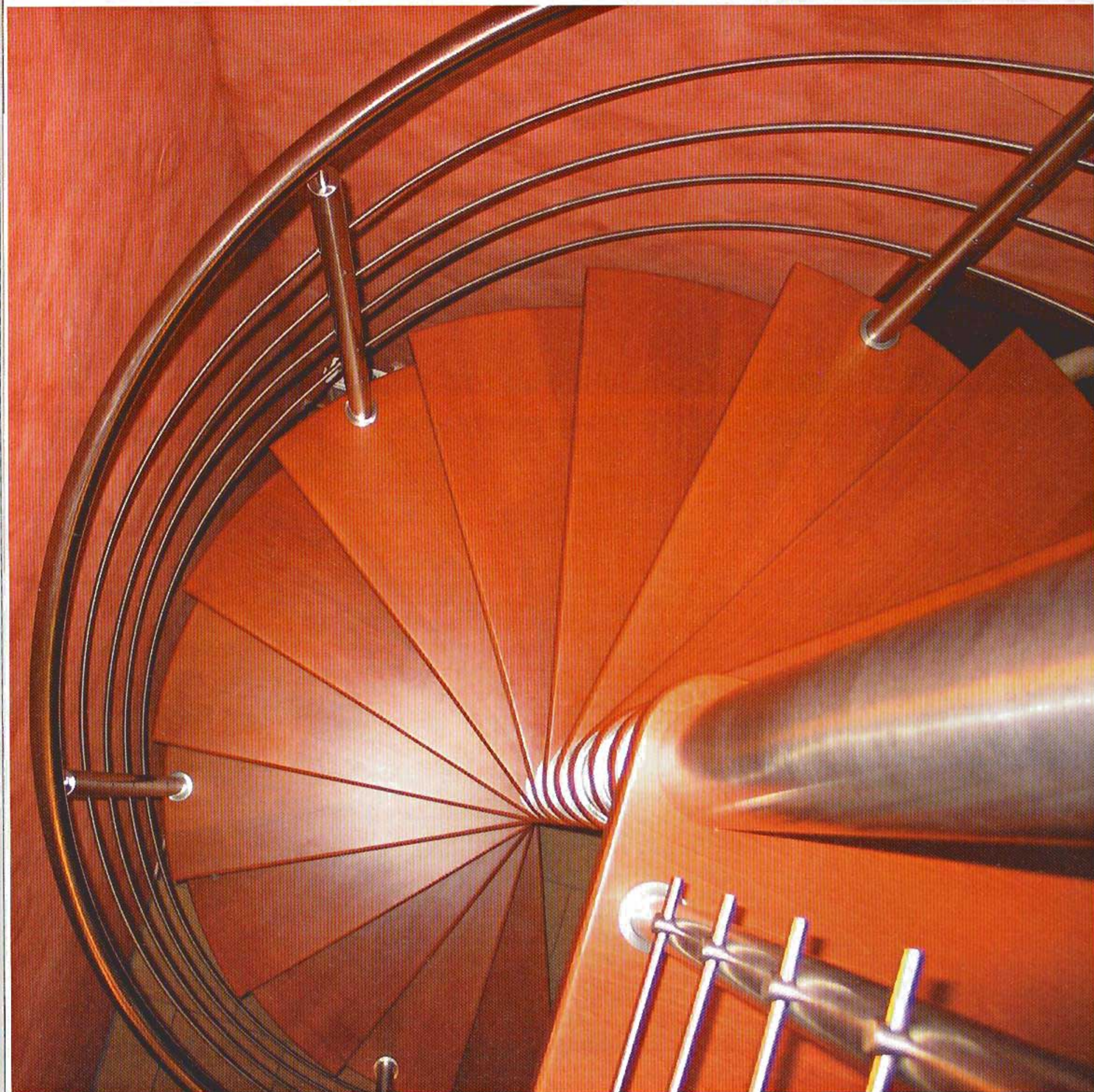
Vřetenové schodiště, kombinace dřeva a kovu
