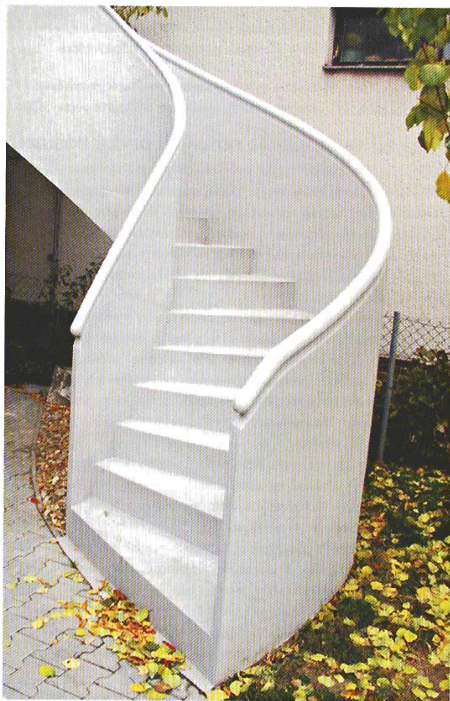
Individuálně, na místě odlité betonové schodiště
