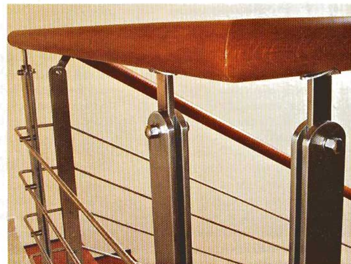
▼ Dřevěná madla s ocelovou, technicky pojatou konstrukcí zábradlí
