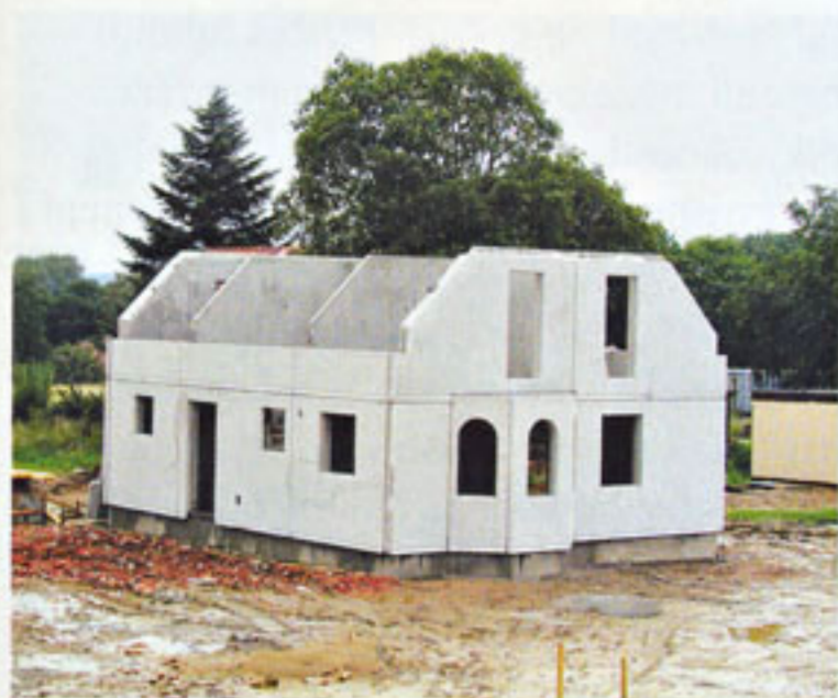
Panelový systém společnosti Canaba: 13 cm silná nosná zeď, přeložená tvrzeným penovým polystyrénem (10 cm Styropor) a přikrytá další 7 cm betonovou vrstvou umožňuje rychlou výstavbu rodinných domů na klíč.
