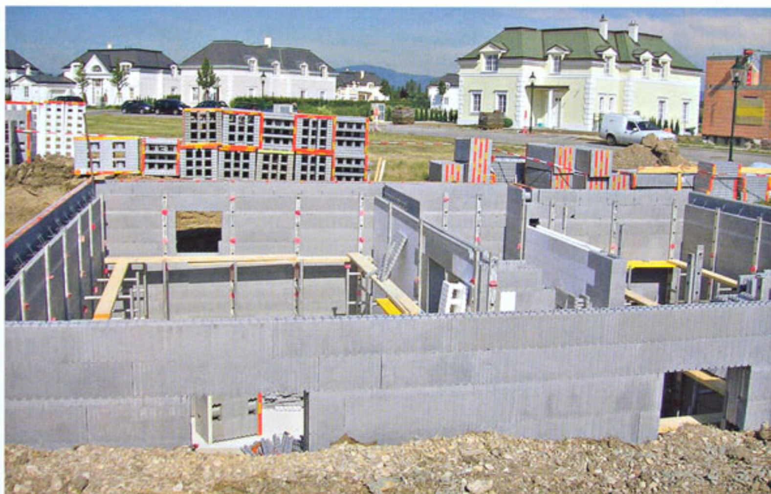
Výstavba rodinných domů metodou ztraceného bednění pomocí přesných tvárnic.
