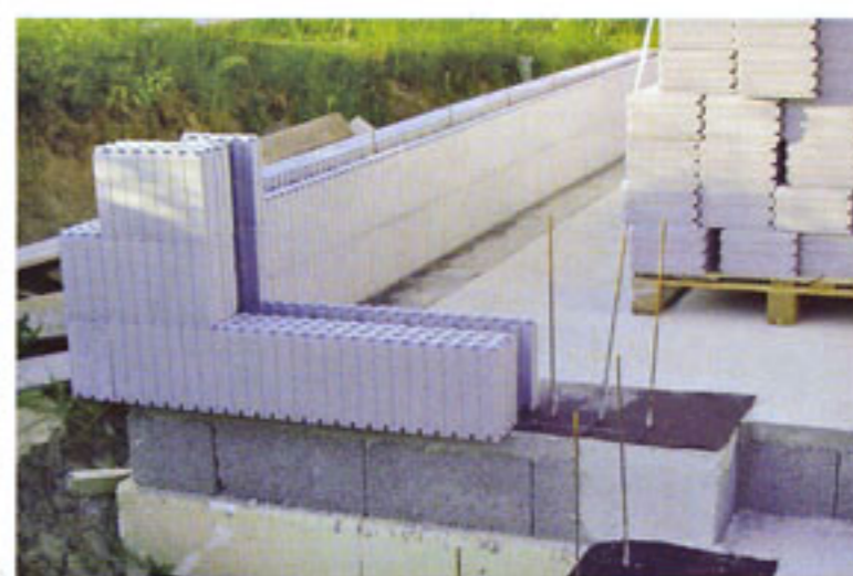
Stavění stěn začíná od rohů. Takto vymezíme vnější rozměry stavby. Po zalití prvních dvou řad jsou stěny stabilní a odolné proti posunu při dalším betonování.
