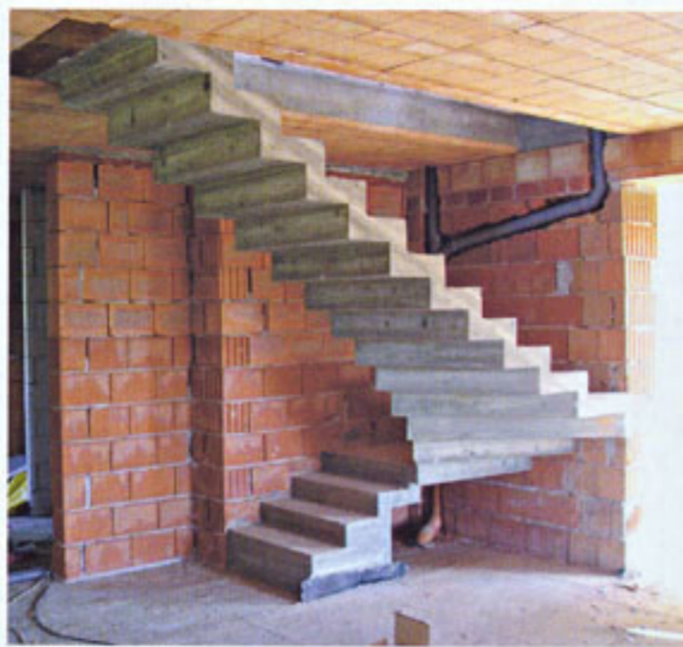
Nezávisle na výběru staviva na vyzdění svislých konstrukcí, schodiště je podle představ investora a architekta zrealizované z betonu. (DNA)
