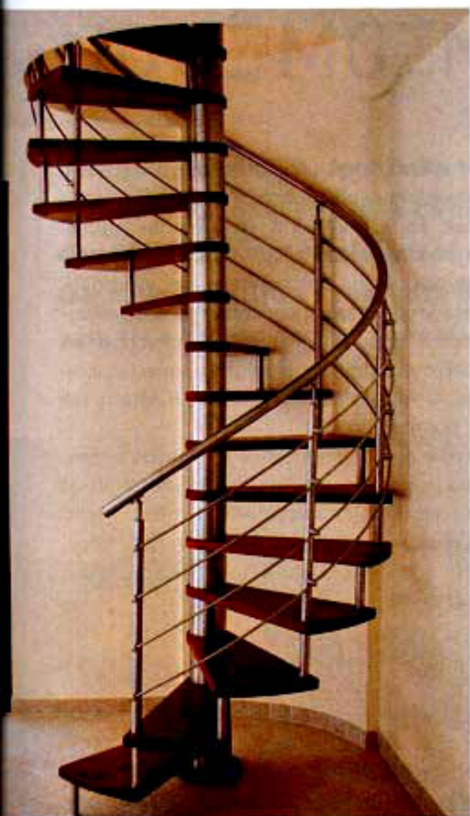
Chcete dlouhodobě předejít statickým problémům? Stačí řádně ukotvit nosné vřeteno z nerezové oceli
